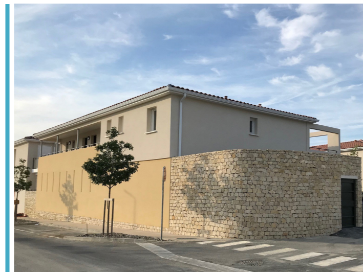
SAINT-DRÉZERY - RÉSIDENCE LES ÉCRINS 13 logements collectifs Architecte : Jean-Luc MARTINEAU
