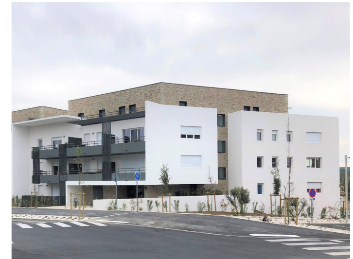
PRADES-LE-LEZ - RÉSIDENCE HORIZON 47 logements collectifs Architecte : Aude SERRADO
