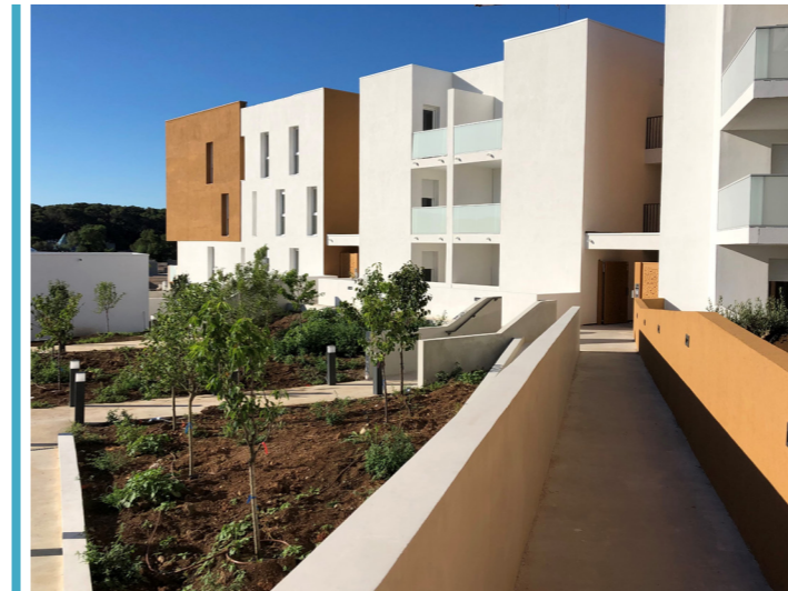
CLAPIERS - RÉSIDENCE LOUIS ARMSTRONG 38 logements collectifs Architecte : Arnaud ROUSSEAU
